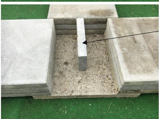
Trennteil für 2 Nist-Einheiten einsetzen
